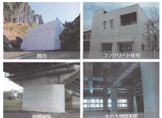
図8 CfFA コンクリートの施工
