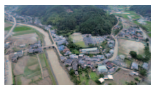
7.8大鶴地区(大肥川・鶴河内川合流箇所)
